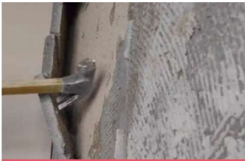
现象二:基层界面层空鼓脱落
